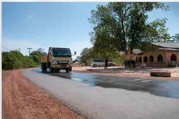
Pengaspalan Jalan Road Construction
